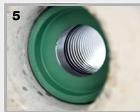
**5.** Das Kabelschutzrohr ist nun druckwasserdicht an die Kernbohrung oder das Futterrohr angeschlossen.
