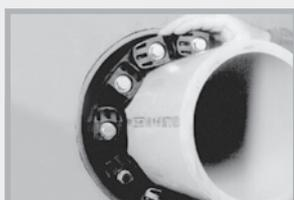
MASTER-SEAL in den Ringspalt einschieben
