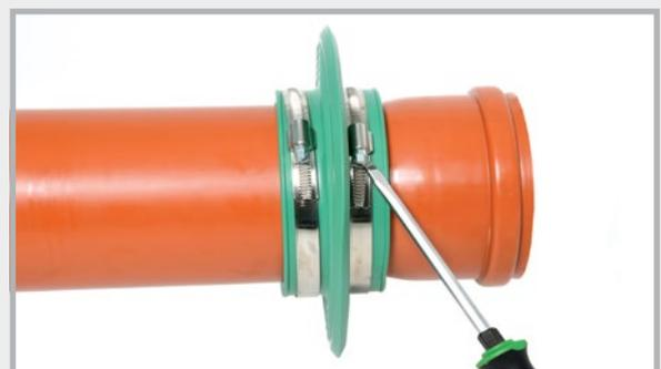
Fixieren durch Anziehen der Spannbänder
