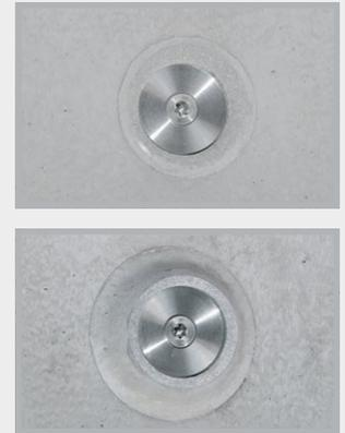
Verschluss bei Muerstärken mit Dichtlippe (oben) oder mit Konus (unten).
