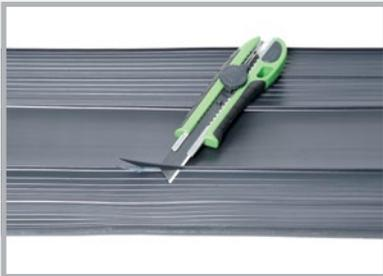
In den Bereichen, wo die Verbinder montiert werden, müssen am Fugenband die Stege entfernt werden.
