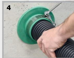
**4.** Mit einem Ringschlüssel die Spannstelle handfest anziehen.
