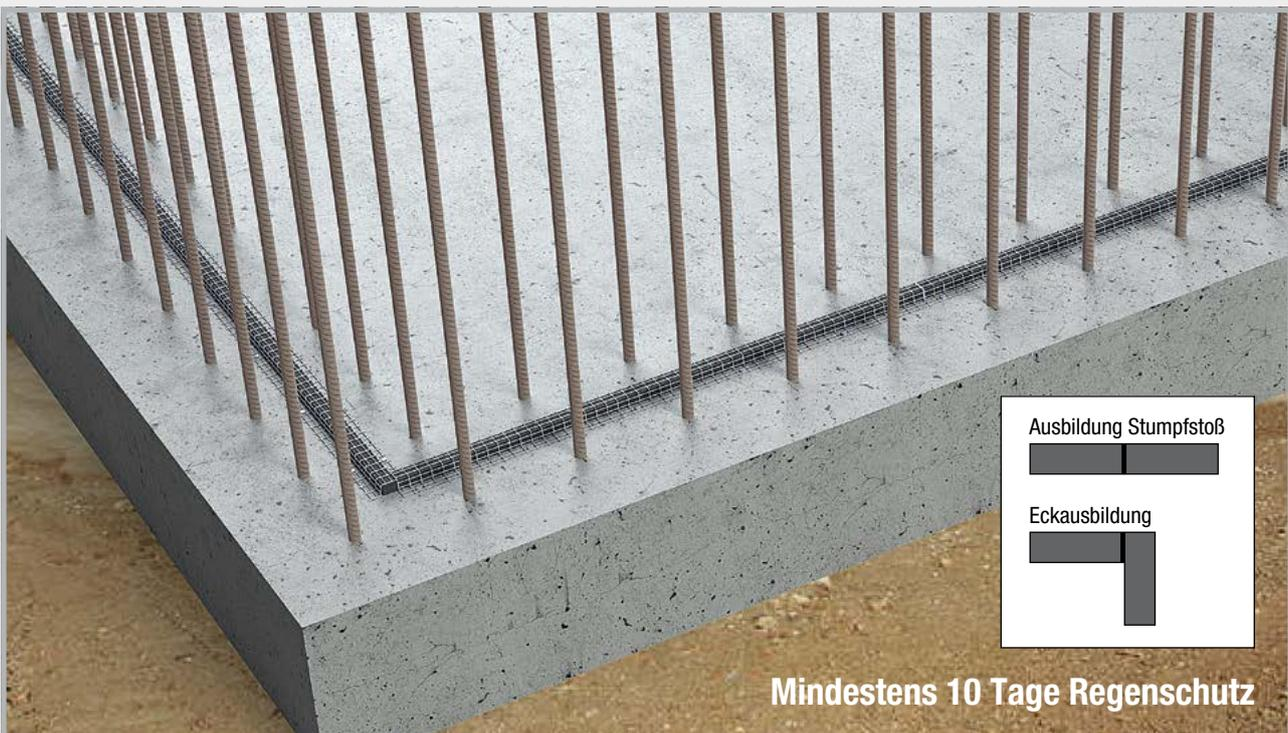
Einbau MASTERSTOP LONG TIME mit Quellbandgitter
