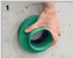
**1.** Die Anschlussdichtung in der Kernbohrung / im Futterrohr positionieren ...
