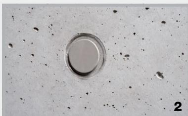
Verschluss Mauerstärke mit Dichtlippe
