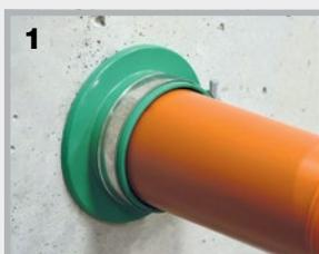
**1.** Der Einbau erfolgt in gleicher Weise wie beim Kabelschutzrohr.
