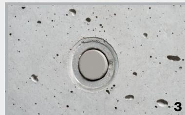
Bündiger Verschluss bei Mauerstärken mit Dichtlippe.
